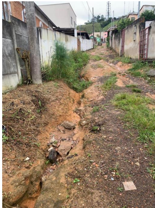
Figura 4 - Atual situação do logradouro a ser pavimentado Fonte: Cristiane Dornelas Saviotti
