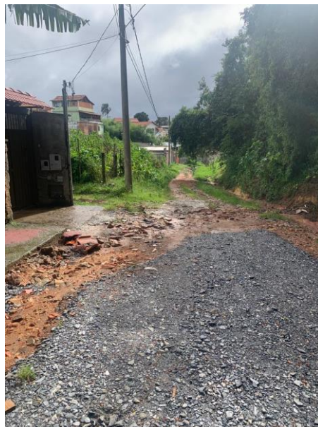
Figura 1 - Atual situação do logradouro a ser pavimentado Fonte: Cristiane Dornelas Saviotti
